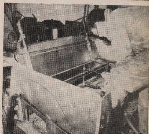
← Fig. 15. — Montage de la tôle support de gâche pour couvercle de malle.
